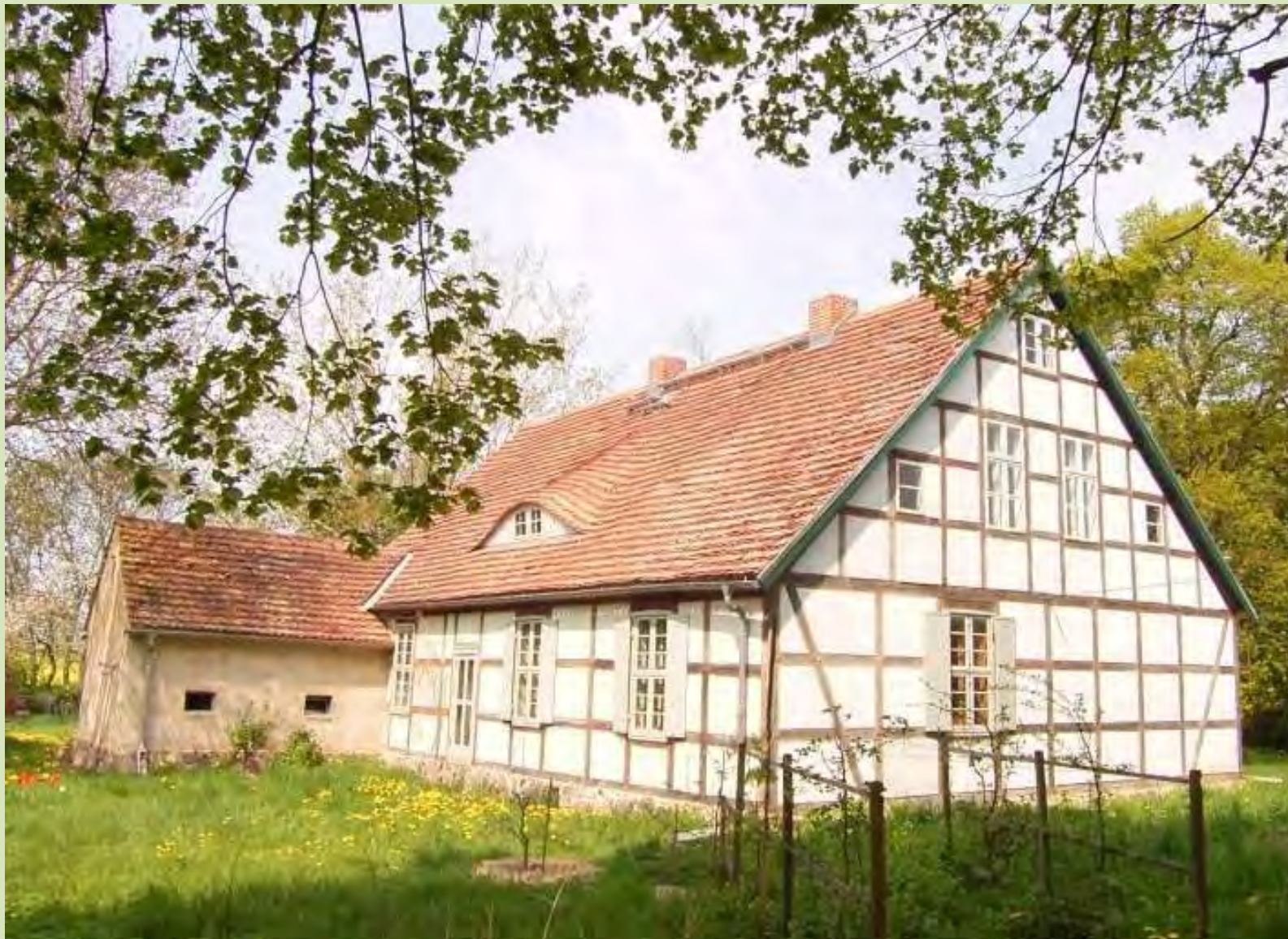
Das ansehnliche, frisch geweißte Fachwerkgebäude mit Sprossenfenstern und Fensterläden steht in ruhiger Lage etwas versteckt hinter dem Friedhof.
