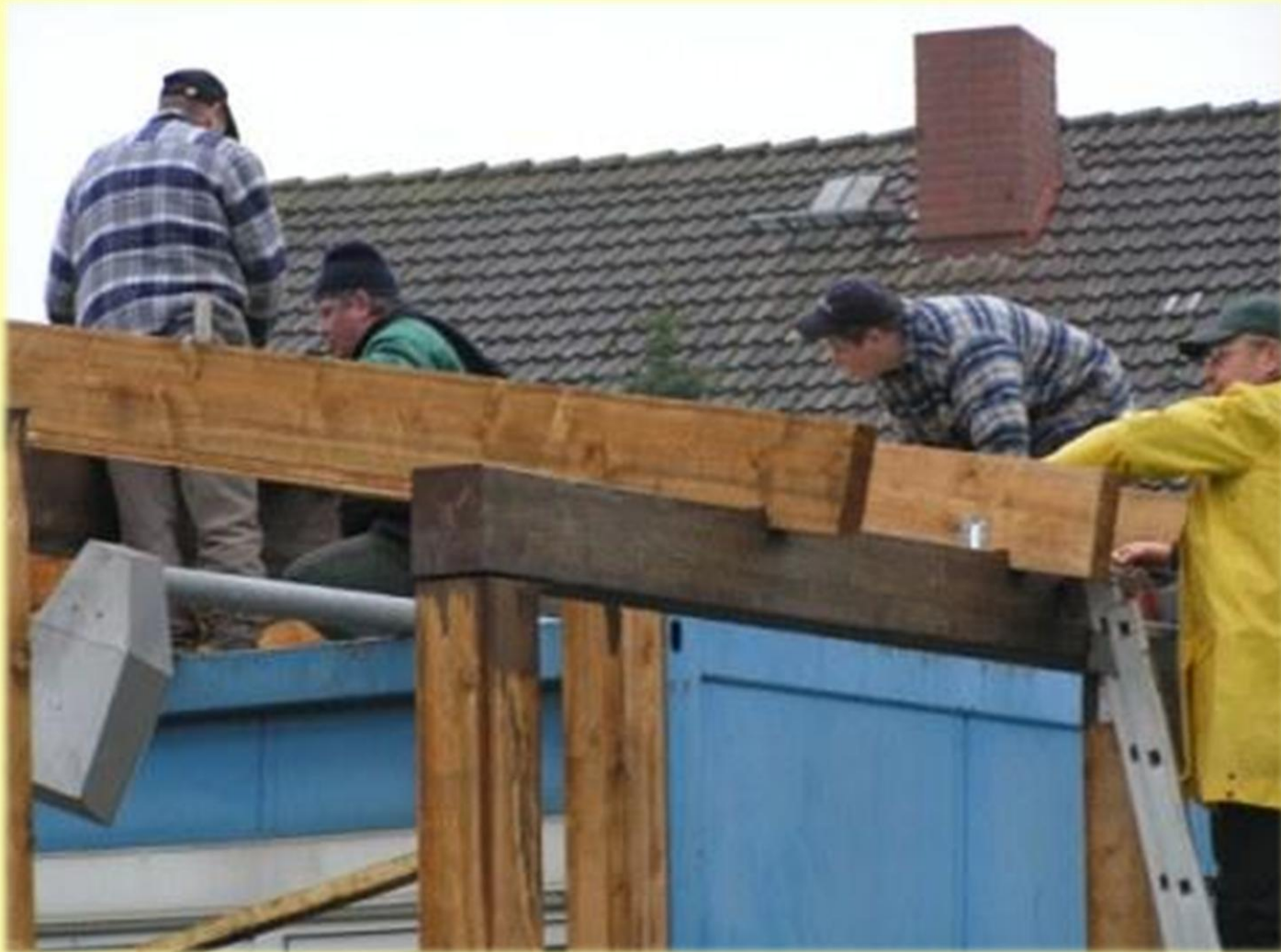
Aufbau der Dachkonstruktion mit Unterstützung von Fachleuten.
