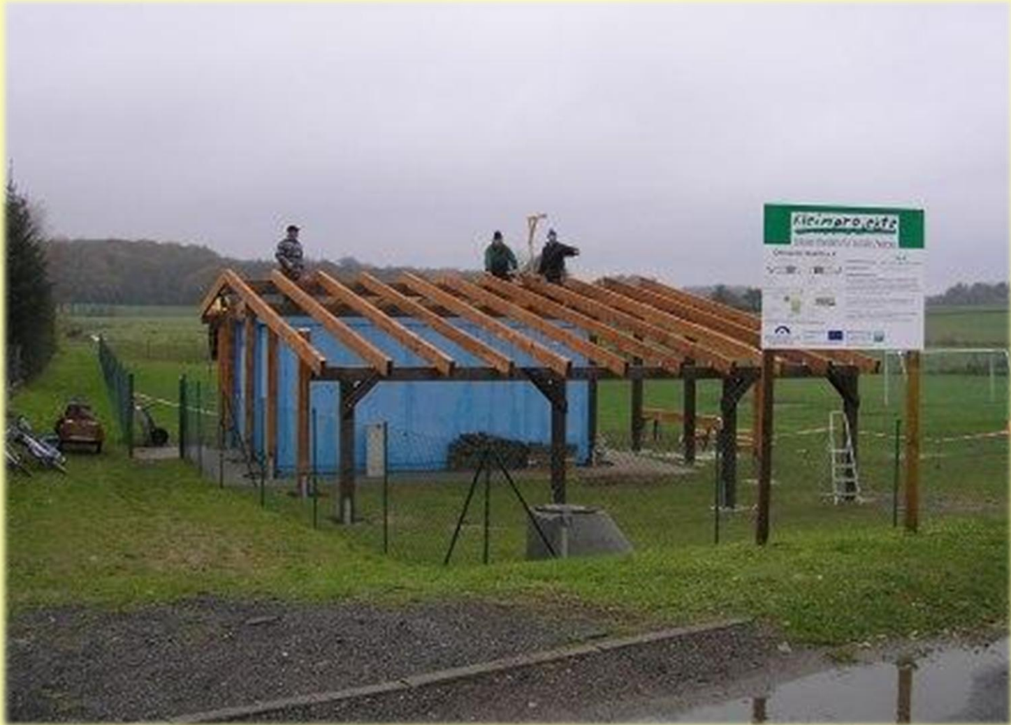
Der Dachstuhl ist fertig!
