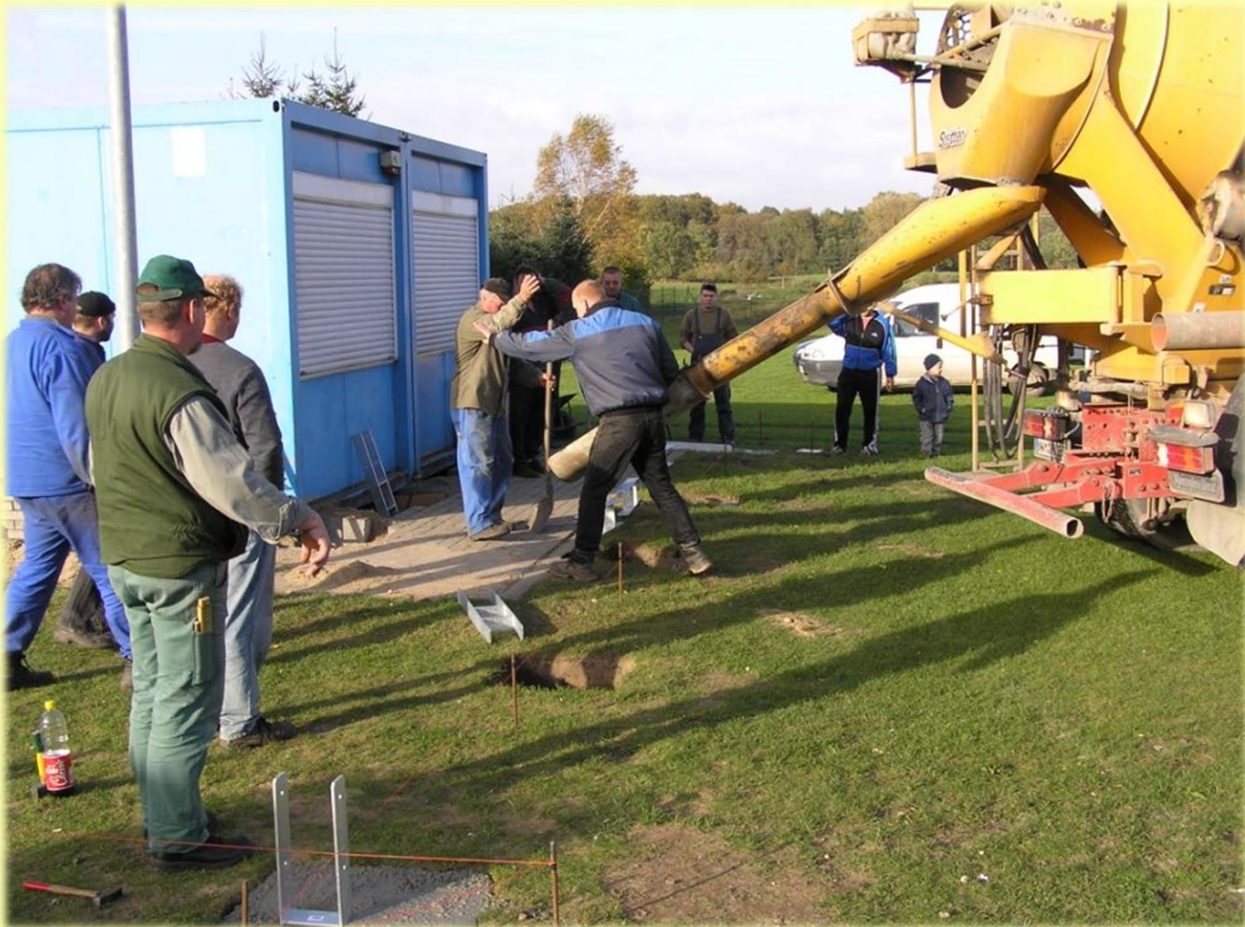
Beginn der praktischen Arbeiten. Betonfundamente werden gegossen.
